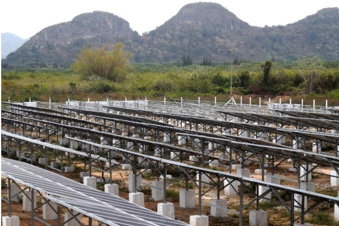
Fig. 20. Parque fotovoltaico «Los Colonos».
